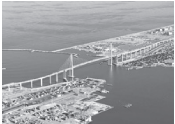
写真-1 新湊大橋
