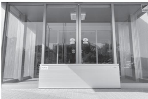
写真-1 建物の出入り口に設置する止水板
