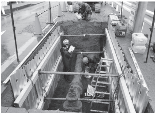
写真－１ 従来の水道管体調査の様子
