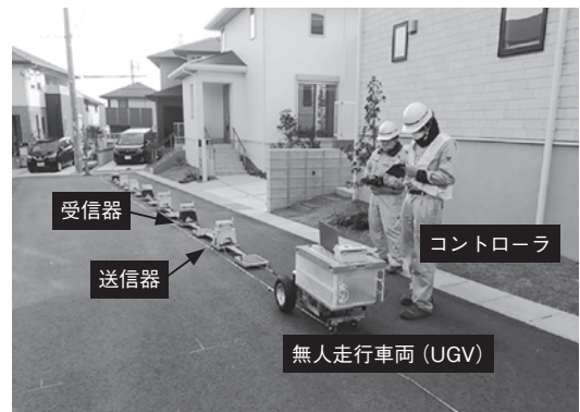
写真－２ 非破壊電気探査の様子
