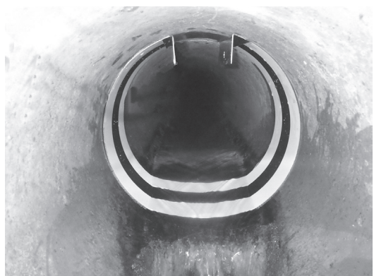
写真-1 リング状指標設置
